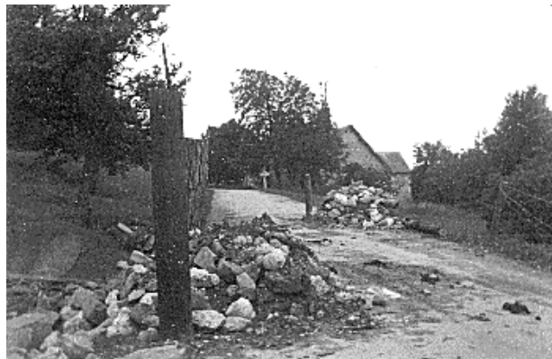
Vue du barrage à l'est du village au moment de son démontage quelques jours après l'armistice.
