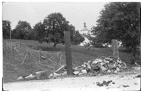
Barrage sur la route à l'est du chef-lieu.
